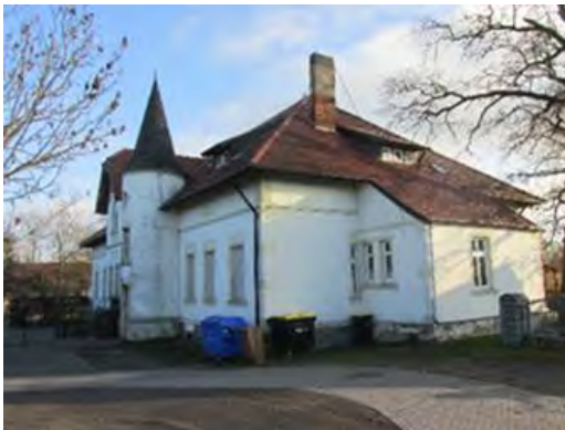
Abb. 18 Der DRK Kreisverband Östliche Altmark e.V. betreibt (wie lange noch?) 70 die Kindereinrichtung „Villa Spatzennest“ in der Gemeinde Hohenberg-Krusemark in der 1904 erbauten »Villa Kroitersch«. (Foto: 30.11.19 Verf.)
